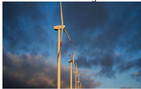
Instalación de energía eólica de Acciona Energía
