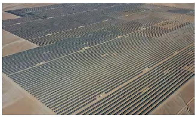
Los paneles cuentan con tecnología monocristalina bifacial, lo que les permite lograr una mayor eficiencia en la captación de la radiación solar. Generan **un 14% más de electricidad que los paneles solares convencionales**.
